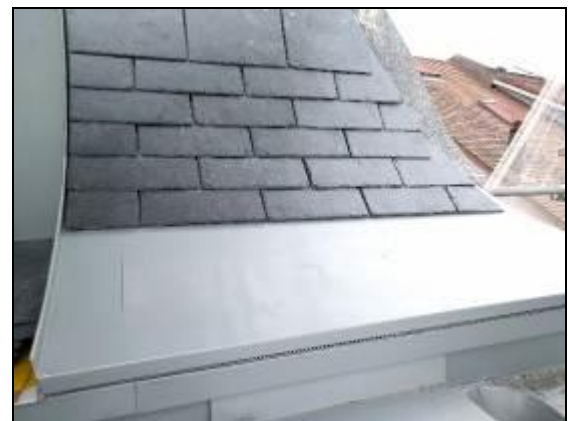
Bild 1 und Bild 2: Sanierung unter Denkmalschutz: Im Mansardendachbereich entspricht kein Bauteil dem Standard. Alle Bauteile aus Titanzink wurden individuell gefertigt.
