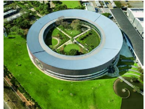
((2354-026-A2-RET)) Das Dach der BMW-Hauptverwaltung erinnert an eine Steilkurve, denn es steigt vom inneren zum äußeren Dachrand deutlich sichtbar an. Zudem vergrößert sich der Radius des Kreises stetig vom Halbkreisbeginn zum Halbkreisende, um sich zum Halbkreisende wieder zu verkleinern. Foto: RHEINZINK
