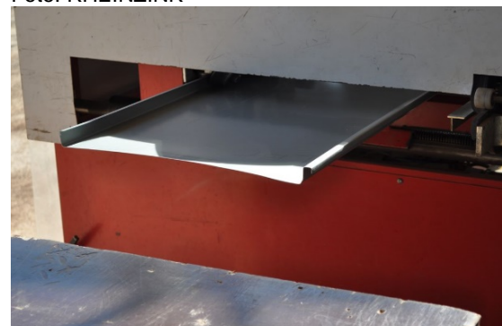
((Datei: 20131002 (46) )) Die Basis für die Anfertigung der Doppelstehfalzprofile bildete ein Verlegeplan. Rohde Roofing hat die Dachfläche -unter Berücksichtigung wirtschaftlicher und arbeitstechnischer Aspekte – gegliedert und die unterschiedlichen Radien aufgenommen und auf die Scharen aufgeteilt. Foto: RHEINZINK
