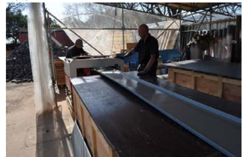
((Bild: 20131002 (32) )) 22,5 t RHEINZINK hat Rohde Roofing in der Baustellenwerkstatt verarbeitet. Foto: RHEINZINK
