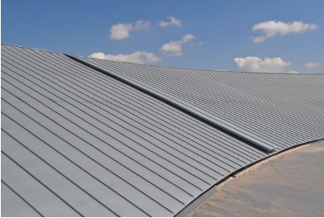
((Bild DSC_6814)) Über den Technikräumen hat Rohde Roofing die Scharen mit Höhenversatz zu den benachbarten Flächen verlegt. Dies dient der besseren Fortführung der Abluft aus der Klimaanlage. Foto: RHEINZINK
