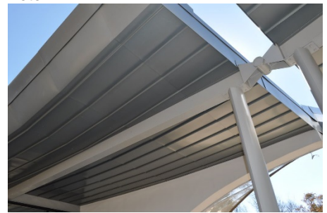
((Bild DSC_7183)) Die Abschlüsse der Gebäudefuge wurden in Einhangfalztechnik ausgeführt. Foto: RHEINZINK
