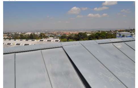
((Bild DSC_6809)) Detail Firstabschluss mit im Versatz verlegten Scharen. Der Höhenversatz dient der Entlüftung einer darunter befindlichen Klimaanlage. Foto: RHEINZINK
