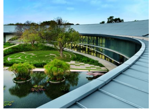
((Datei: 2354-017-A3-RET)) Die Dachfläche der Erweiterung wurde analog zur großen Dachfläche in Doppelstehfalztechnik gedeckt. Den Dachabschluss zum Innenhof bildet eine Mauerabdeckung mit Ausschnitten für die Doppelstehfalze. Foto: RHEINZINK
