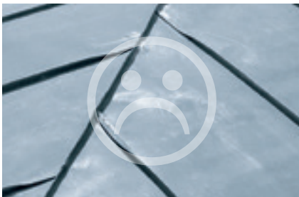
Nároží nebo hřeben jako dvojitá stojatá drážka
