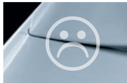
Hřeben pultové střechy bez mezery pro pohyb a s příliš nízkým zdvihem
