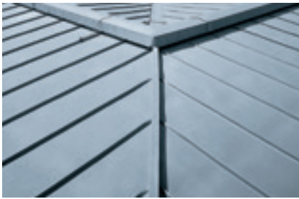
Nároží s lištou a krycím profilem
