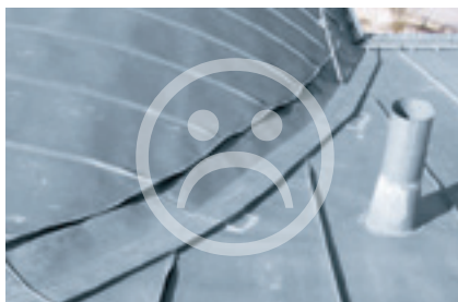
Úžlabí na dvojistou stojatou drážku (nafalcované úžlabí)
