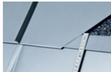
Příčný spoj jako jednoduchá ležatá drážka
