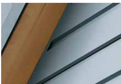
Oldalsó lezáróelem – vízszintesen szerelt oromfalburkolatnál
