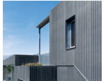
SHV SullnerHaus Vorarlberg, Sulz, Austria
