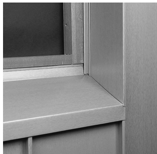
Fig. 21: Lysåpning til sideavslutning sålbenkbeslag
