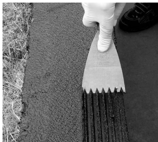
Fig. 4: Enkolit® påføres med rillet sparkel
