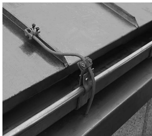
Fig. 9: Fagmessig korrekt tilkobling vil ikke hindre banenes termisk betingede lengdeendringer
