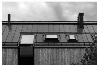
Fig. 6: Takområde med mange gjennomføringer
