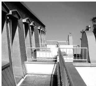
Fig. 26: Bruk av RHEINZINK-beslagsprofil ved murdetaljer
