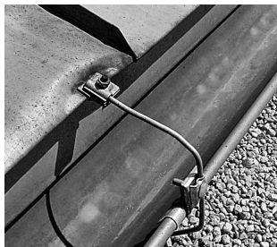
Fig. 10: Feilaktig tilkobling av lynvernklemmen til banene
