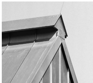
Fig. 11: Fluktende møneavslutning på vindski, høy utførelse
