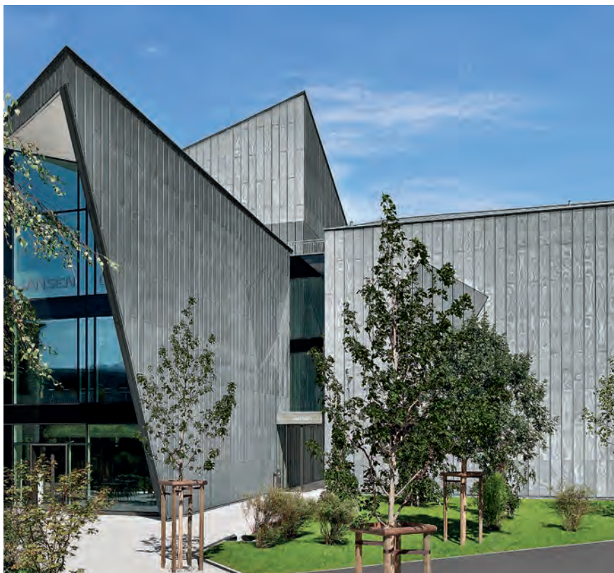
Офисное здание Jansen Campus, Оберриет, Швейцария
