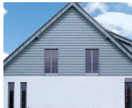
Двускатная кровля на частном доме
