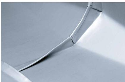
**Соединение фальца с двумя конвертами с поперечным швом (3)**
