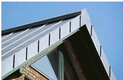
**Вентилируемый конёк двускатной крыши, высокое исполнение**
