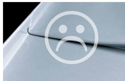
**Конёк односкатной кровли без деформационного зазора и с недостаточным подъёмом**
